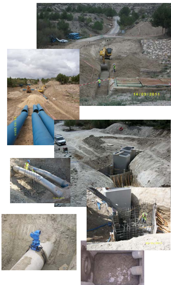
EJECUCIÓN ZANJA, MONTAJE TUBERÍA FD Y PREPARACIÓN DE PIEZAS ESPECIALES Y DADOS DE ANCLAJE
