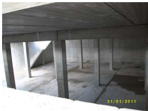
INTERIOR DE UNO DE LOS VASOS: VIGAS Y PLACAS PREFABRICADAS
