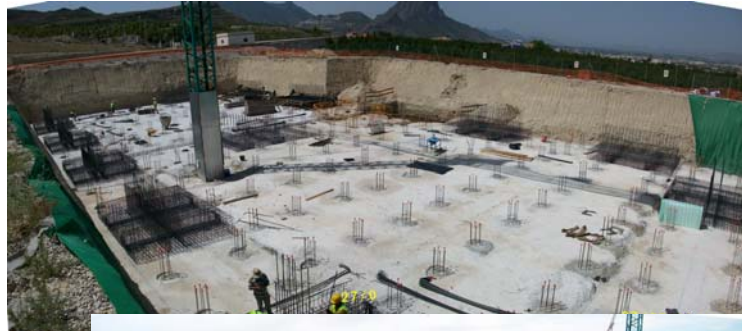
CIMENTACIÓN MEDIANTE PILOTAJE IN-SITU
