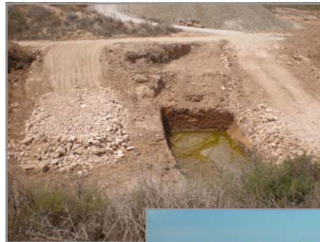
PROCESO DE EJECUCIÓN DE LOS DIQUES DE GAVIONES Y ADECUACIÓN DE LAS MÁRGENES CON ESCOLLERA
