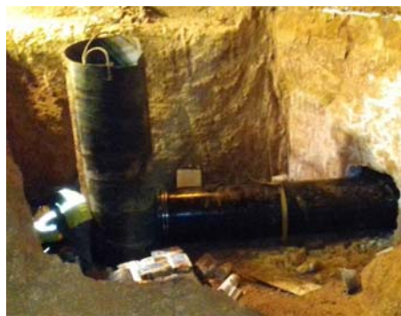
PROCESO CONSTRUCTIVO DEL TANQUE LAMINADOR
