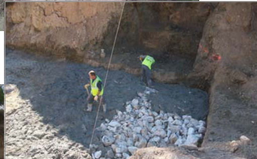
PROCESO DE EJECUCIÓN DE LOS DIQUES DE MAMPOSTERÍA HIDRÁULICA Y LAS ALBARRADAS Y DIQUES DE MAMPOSTERÍA GAVIONADA.
