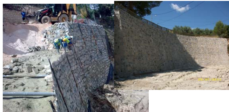
EJECUCIÓN DE MURO DE MAMPOSTERÍA HIDRÁULICA DE 7 MTS ALTURA
