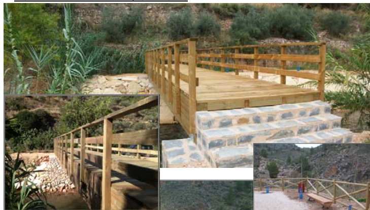
PASARELA EN MADERA LAMINADA, LUZ DE 15 MTS
