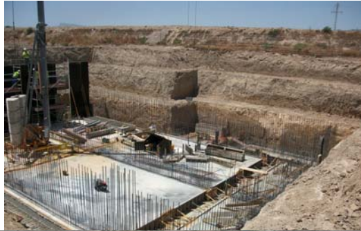
PROCESO CONSTRUCTIVO DEL TANQUE LAMINADOR
